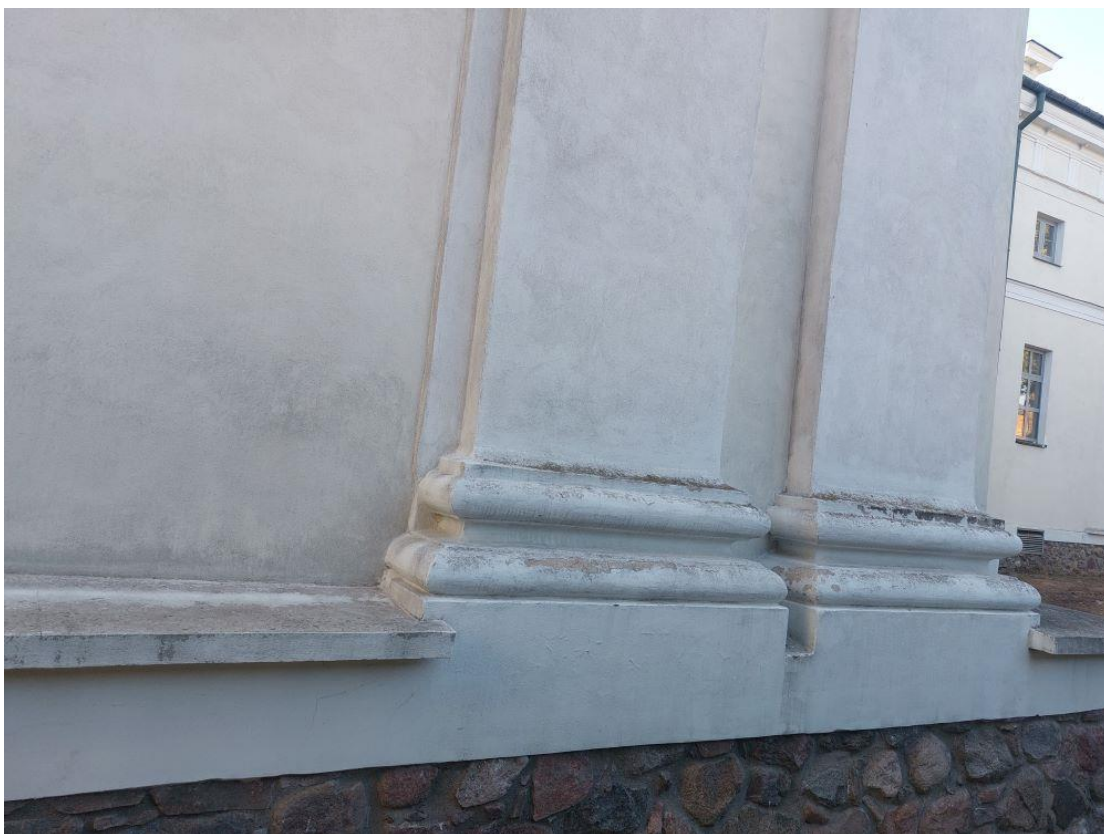
Foto. 12 Elew. Wschodniej kaplicy_zasolenia_pleśnie_odbarwienia
