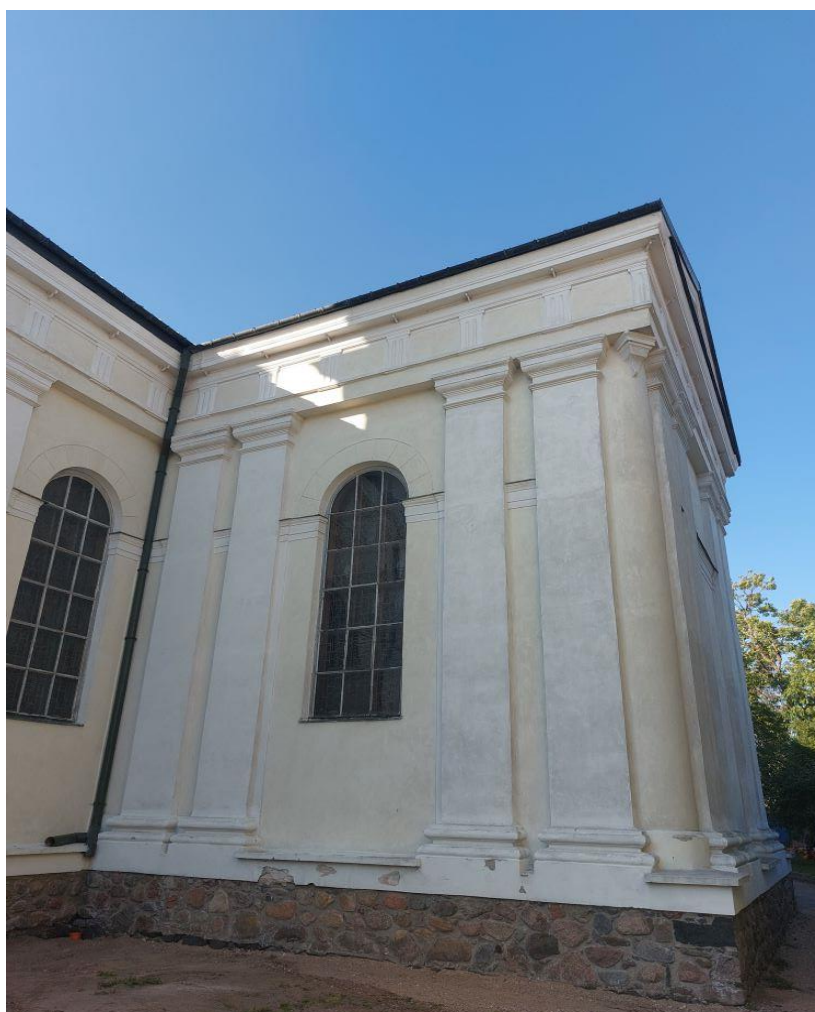
Foto. 12 Elew. Wschodniej kaplicy_zasolenia_pleśnie_odbarwienia
