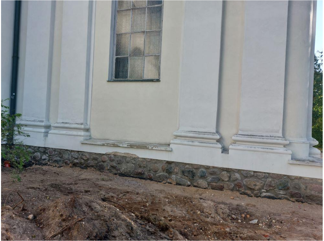
Foto. 16 Elewacja zach. Kaplica zachodnia_przyziemienie. Widoczne liczne ubytki, zmiany biologiczne i chemiczne.
