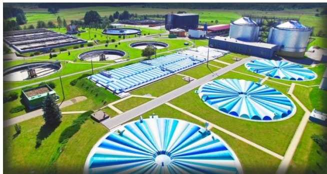
Oczyszczalnia ścieków, fot. z archiwum Przedsiębiorstwa Wodociągów i Kanalizacji w Suwałkach Sp. z o.o.
