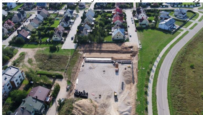
Budowa zbiornika retencyjno-rozsączającego na wody opadowe - Osiedle Hańcza, fot. z archiwum Przedsiębiorstwa Wodociągów i Kanalizacji w Suwałkach Sp. z o.o.
