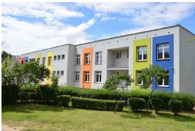
Przedszkole nr 7 po remoncie, fot. z archiwum Urzędu Miejskiego w Suwałkach
