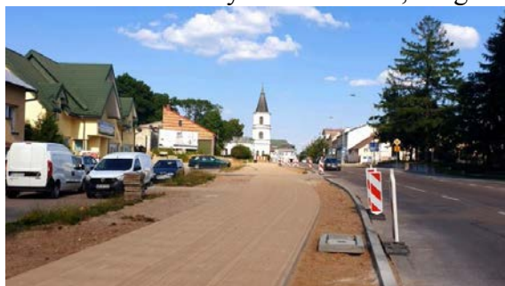
Budowa chodnika- ul. Mickiewicza, fot. z archiwum ZDiZ w Suwałkach
