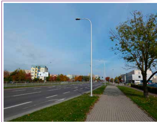
Wymiana słupów oświetlenia ulicznego na ul. Generała Kazimierza Pułaskiego, fot. z archiwum ZDiZ w Suwałkach.
