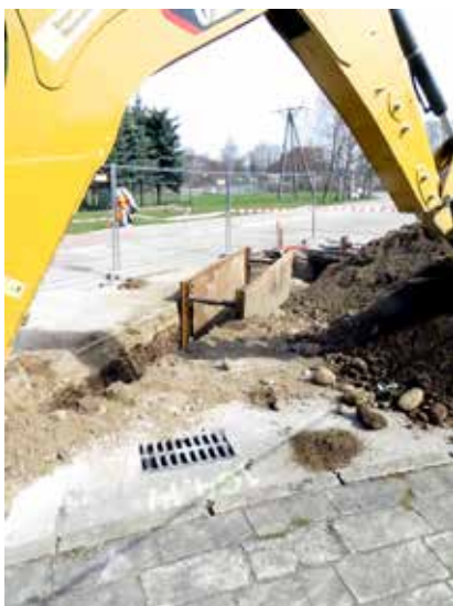
Budowa sieci kanalizacji sanitarnej ul. Pogodna.
