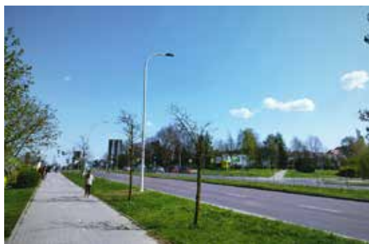
Wymiana słupów oświetlenia ulicznego na ul. gen. K. Pułaskiego oraz wyremontowany chodnik na ul. Powstańców Wielkopolskich.
