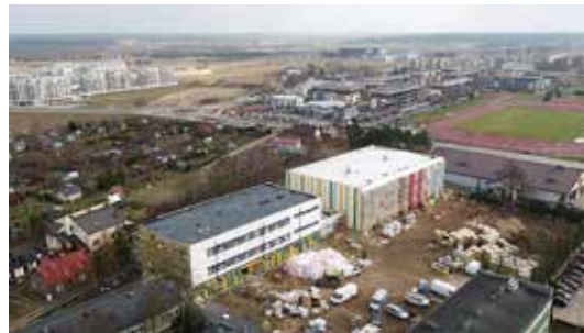
Rozbudowa Szkoły Podstawowej nr 4 w Suwałkach.
