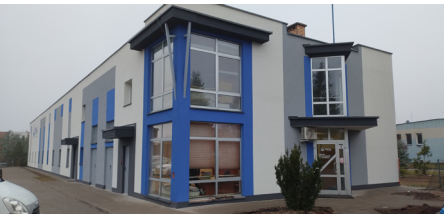
Budynek pomp II stopnia, ZWiK; fot. z archiwum PWiK w Suwałkach Sp. z o.o.
