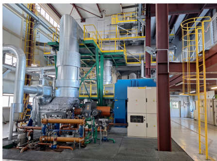
Turbozespół kogeneracyjny; fot. z archiwum PEC w Suwałkach Sp. z o.o.
