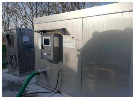
Stacja zlewna; fot. z archiwum PWiK w Suwałkach Sp. z o.o.
